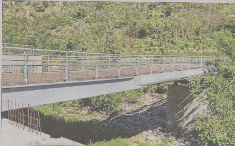
Selon Thierry Ruf, en cas de crue cévenole, la Bourges pourrait emporter la passerelle construite dans le lit de la rivière. Projet porté par la Famille Missionnaire qui a par ailleurs obtenu un permis de construire.
