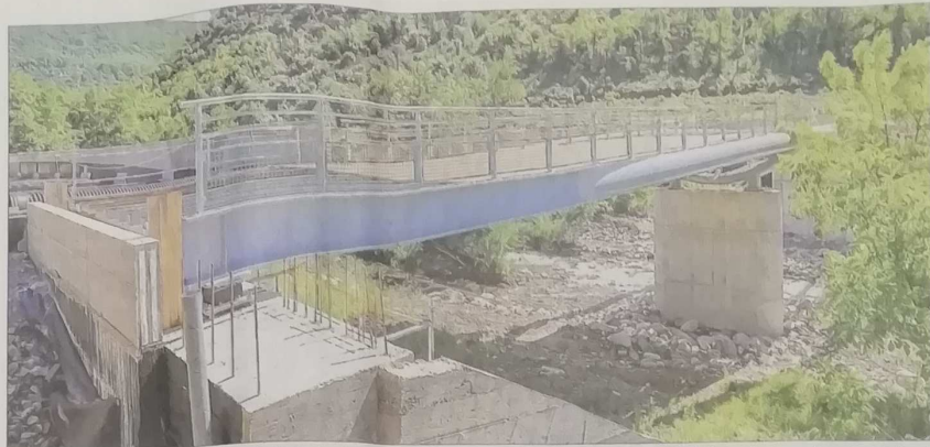
Le projet de la Famille missionnaire de Notre-Dame, prévu à Saint-Pierre-de-Colombier (Sud-Ardèche), est fortement contesté. Avant que les travaux ne soient suspendus pendant plus de deux ans, la passerelle avait déjà été construite. Photo Le DL/Anthony GONZALEZ
